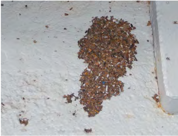
Air intake plenum (rust debris)
