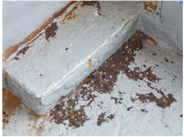
Air intake plenum (rust debris)
