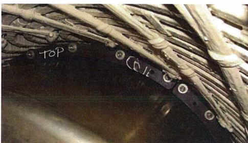
CE Air Gap Baffle Top
